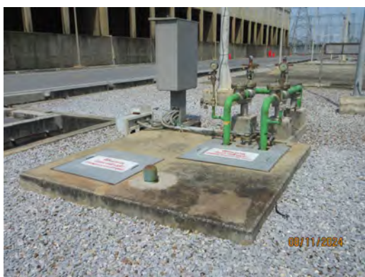
ภาพที่ 2-17 บ่อแยกน้ำมัน (Oil Separator)
